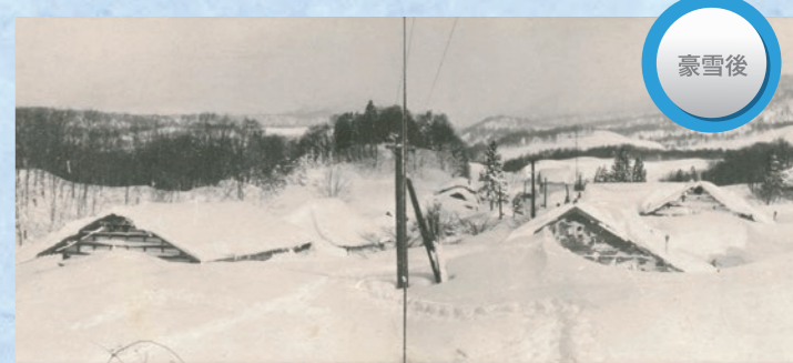
※当時は、雪の下のトンネルを通して生活していた。
